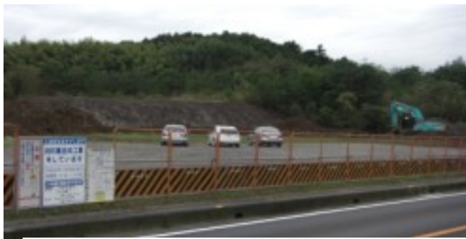
造成工事が始まった上横田の新消防署建設予定地
